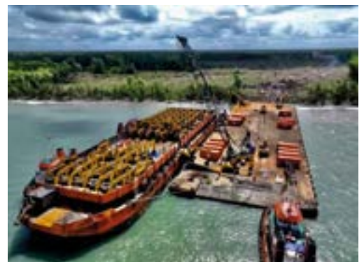
Ankunft der Bagger und Bulldozer
